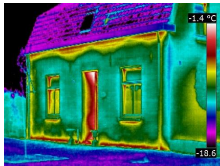
Controle van een na geïsoleerde gevel
